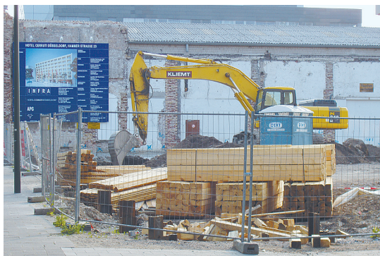
Noch haben die Bauarbeiter das Sagen, doch Richtfest war schon.
