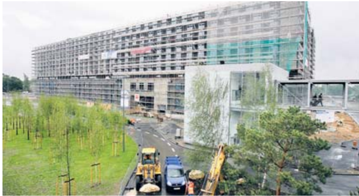
Der Rohbau des Maritim-Hotels am Flughafen ist bereits fertig gestellt worden. Es wird insgesamt 533 Zimmer anbieten können. RP-FOTO: WERNER GABRIEL
