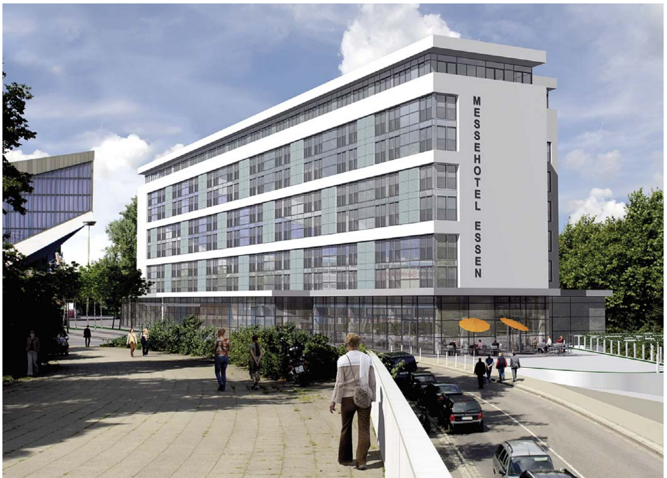
Das im Bau befindliche Hotel an der Messe wird mit 248 Zimmern das zweitgrößte Haus in Essen.
